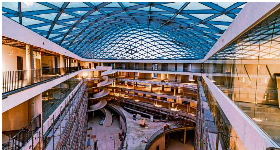
Der Neubau vereint alle Fachbereiche der Fakultät Technik. Foto: DHBW Stuttgart
