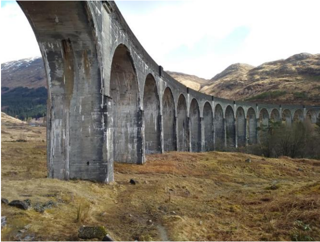
Glenfinnan Viadukt („Harry Potter Brücke“)
