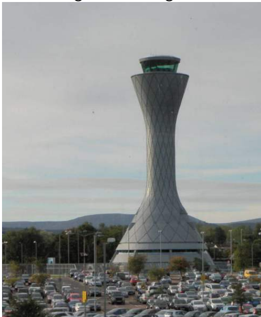
Kontrollturm am Flughafen Edinburgh
