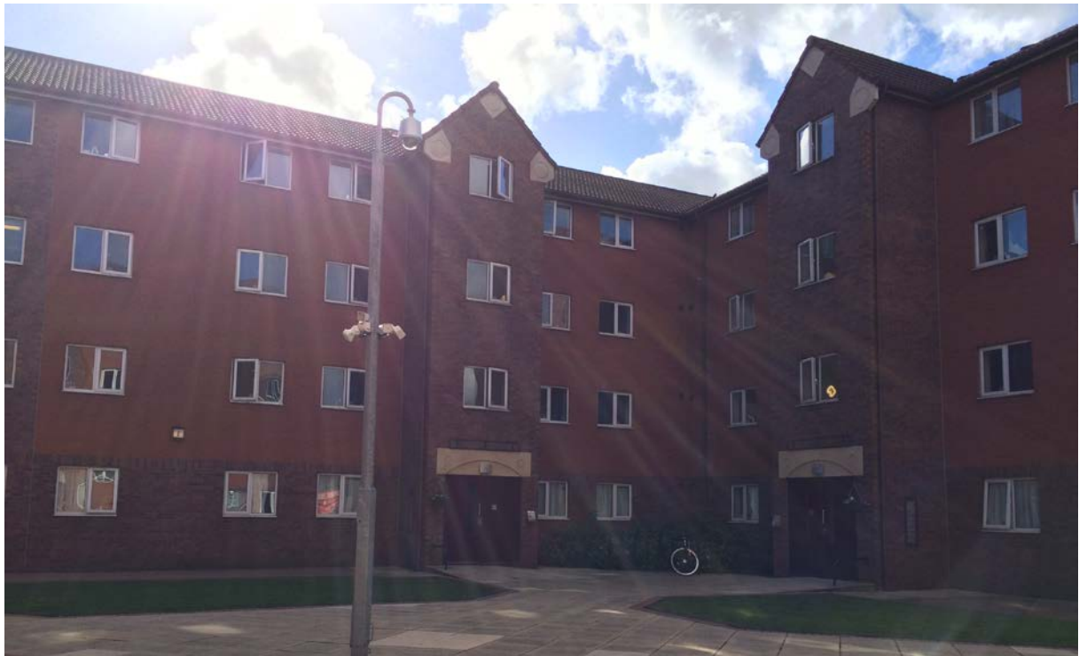
Die Wohnheimanlage mit dem gemeinsamen Innenhof
